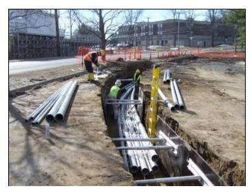
Figure 15 - Underground Distribution Conduit Installation
